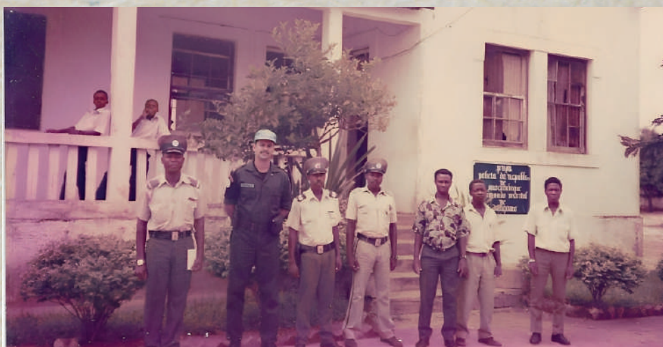
Figura 05: Inspeção a um Posto Policial na Província de Inhambane, Moçambique.
